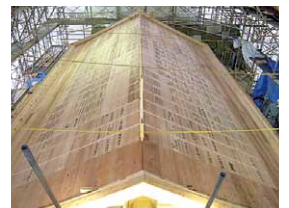
野地板の施工完了
