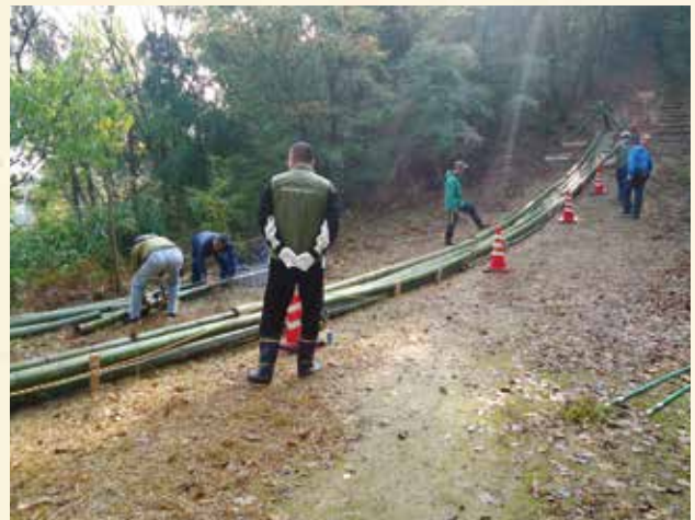
長さ20mの竹スライダー設置
