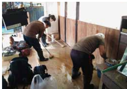
◀ 泥で汚れた床の清掃
